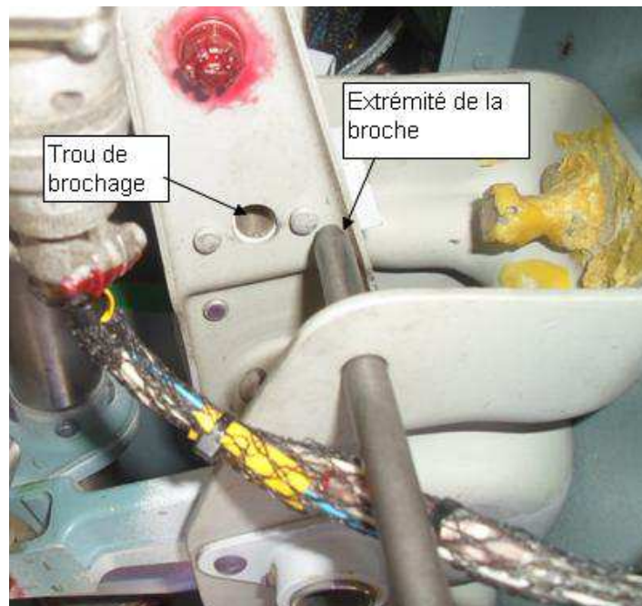
Essai de brochage au niveau du renvoi de commande sur l'axe de roulis
