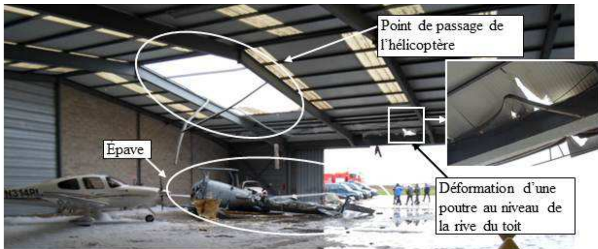
Vue intérieure du hangar
